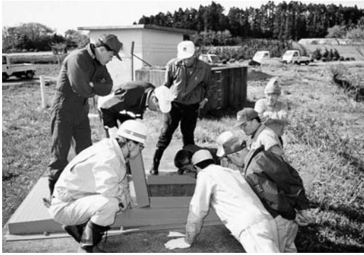
浪江地域の末ノ森水路流域（末ノ森・田尻・川添・樋渡・牛渡・幾世橋・権現堂）の施設調査
