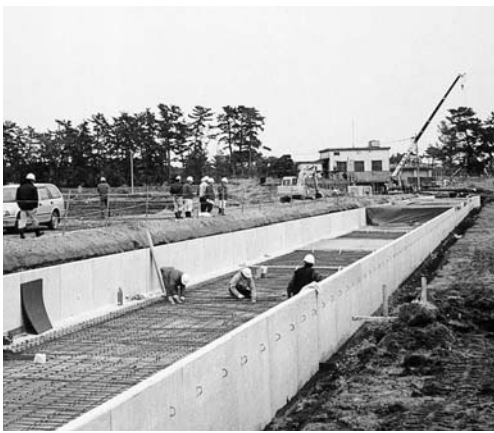
県営ほ場整備事業大井・塚原地区 大型排水路工事状況
