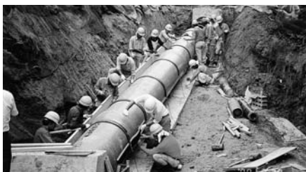
パイプライン新管 800mm の設置・斜面コンクリート打設準備状況
