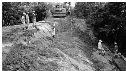
パイプライン新管 800mm 埋戻状況
