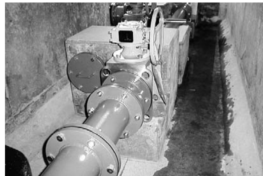
井手分水工の多孔式弁を バタフライ弁に改良
