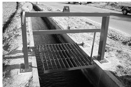
県営用水路に 手動式ゴミスクリーンを設置
