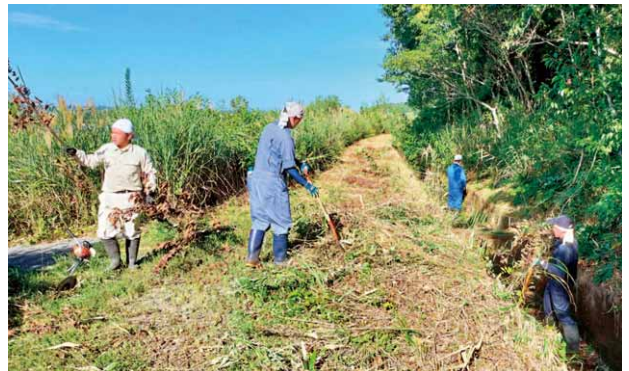
令和5年8月／青根場用水路（浪江町）環境整備
