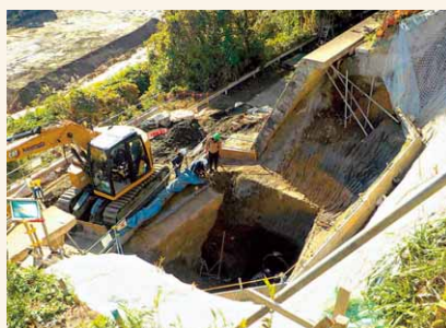
工事箇所上部より
