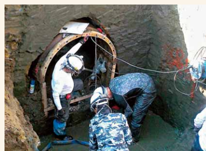
トンネル断面 (補強作業)
