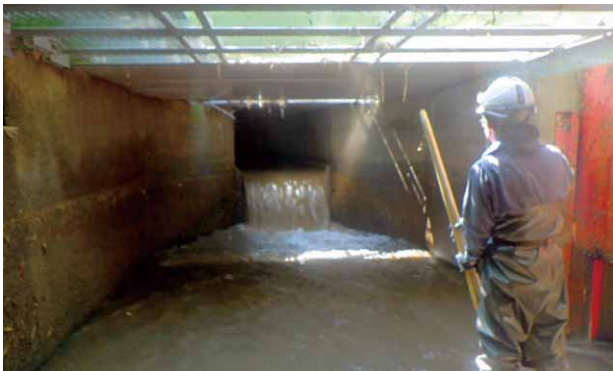
令和5年7月／請戸用水路（浪江町）通水作業
