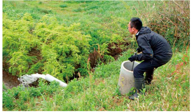
令和5年4月／放森分水（小高区） 請戸左岸幹線かんがい通水作業
